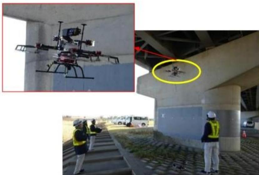
図4-19 ロボットやドローンを使用した測量・調査の事例
